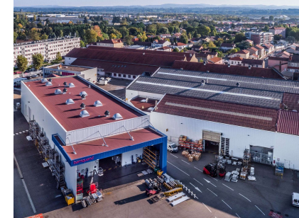
Achat d'un terrain à Roanne pour agrandir le site industriel (2000m 2 )
