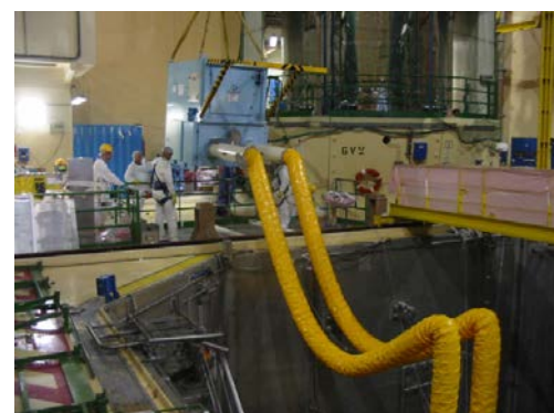
Installation d'une MED CP ® sur un faux-couvercle pour la mise en dépression du circuit primaire.
