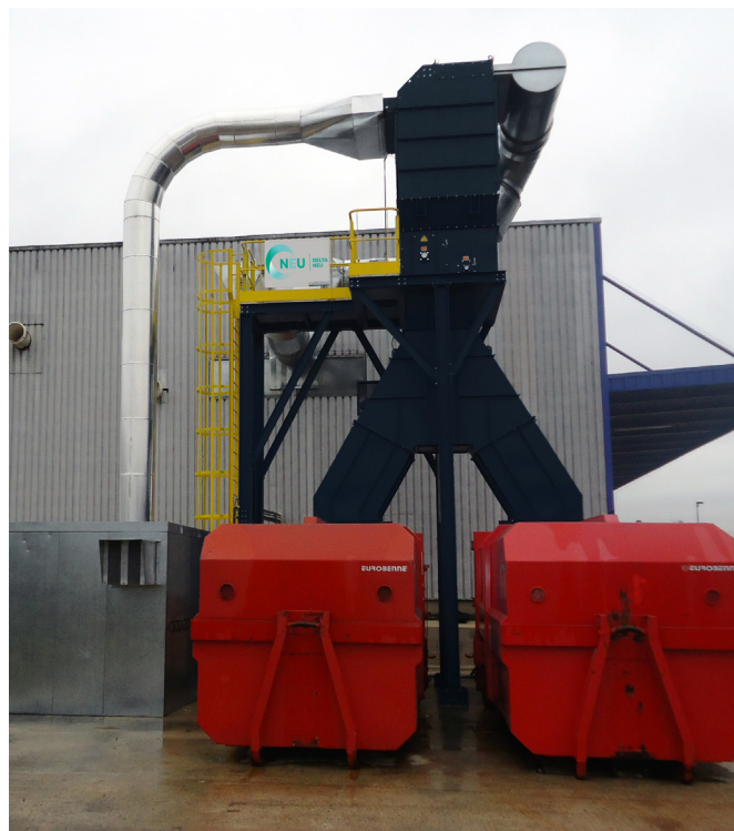
Pneumatisch afvalinzamelingsysteem met SEPAROJET M en CHOPPERLINE
